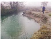
Foto 6: manufatto idraulico ammalorato ed erosione spondale sul cavo Terdoppio
