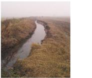
Foto 2: erosioni di sponda sul cavo Terdoppio
