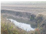
Foto 3: erosioni di sponda sul cavo della Macchina
